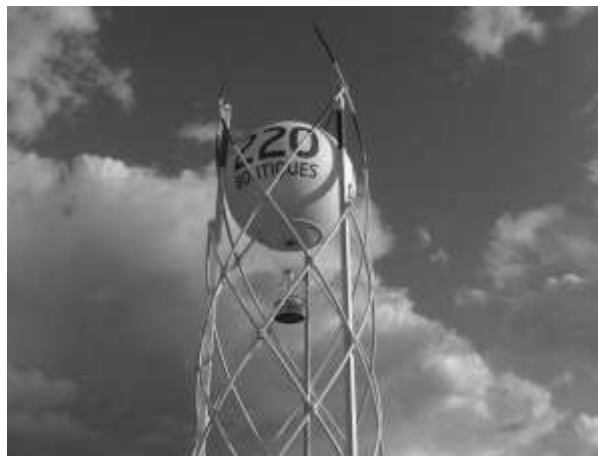
Figura 2.7 – Aerophare posta nel centro commerciale O'Parinor in Aulnay sous Bois (Francia)
